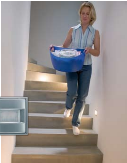
Bewegungsmelder im Treppenhaus oder Flur schalten die Beleuchtung automatisch ein und aus.
