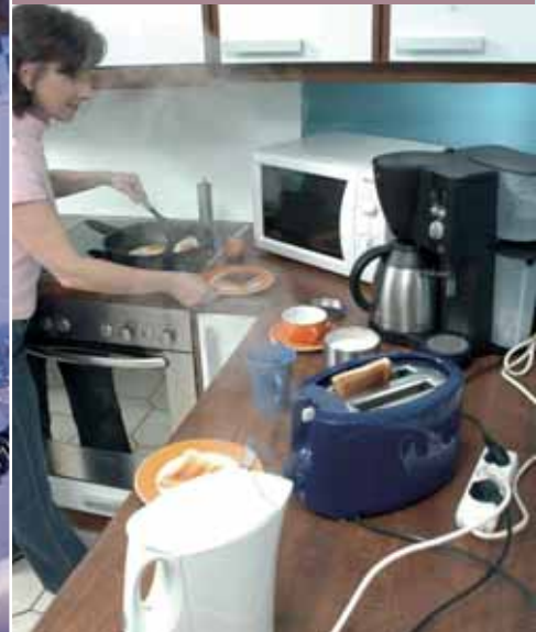
Vor allem in der Küche führt der Einsatz von Steckdosenleisten schnell zur Überbelastung der Elektroanlage.
