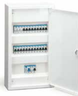
FI-Schalter werden in den Stromkreisverteiler eingebaut.
