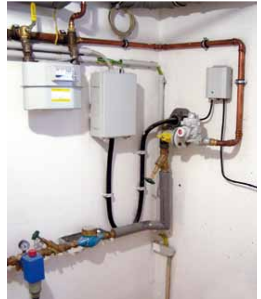
Beispiel einer Hausanschlusswand (oben)
